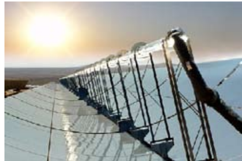
شكل ٤ : تقنية المركّزات الشمسية ذات القطع المكافئ الأسطواني
