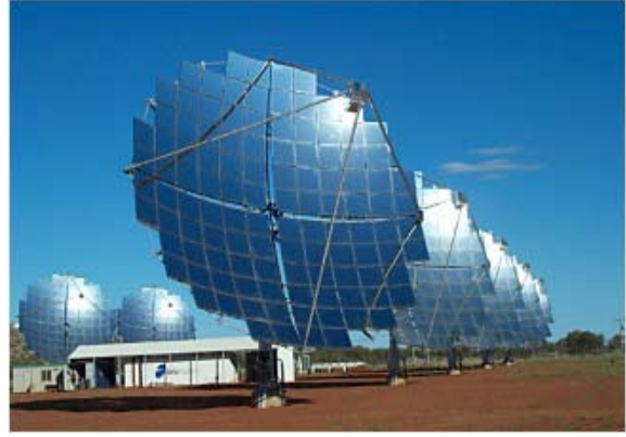
شكل ٣ : المركّزات الشمسية ذات القطع المكافئ الدائري
