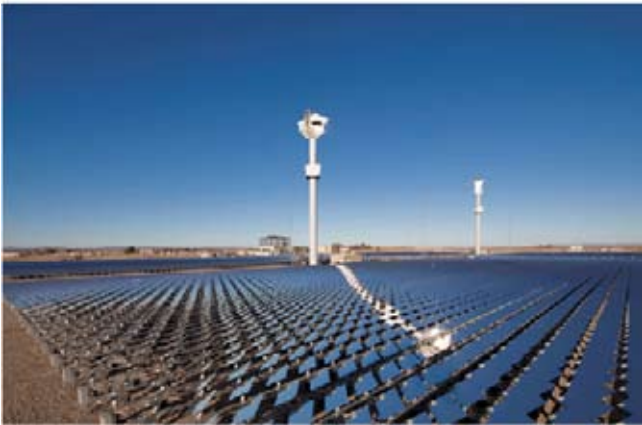
شكل ٥ : تقنية البرج المركزي
